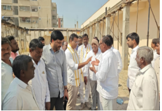
నాయకులు మాజీ ముఖ్యమంత్రి కేసీఆర్ అన్నారు. అనంతరం నిర్మాణ దశలో ఉన్న కమ్యూనిటీ హాల్ పనులను ఎమ్మెల్యే కె.పి.వివేకానంద్ పరిశీలించి కమ్యూనిటీ హాల్ నిర్మాణ పనులను త్వరితగతిన పూర్తి చేయాలని, కమ్యూనిటీ హాల్ నిర్మాణానికి తన
