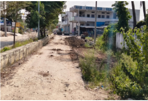
అధికారులు, ప్రజాప్రతినిధులను కోరినా స్పందన లేకపోవడంతో గ్రామస్థుల్లో అసంతృప్తి నెలకొంది. సీసీ రోడ్డు పనులను వెంటనే పూర్తి చేయాలని ప్రజలు కోరుతున్నారు.
