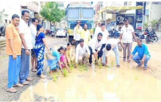
అశోక్ నగర్ కాలనీ వాసులు రోడ్డుపై ఏర్పడిన భారీ గుంతల
